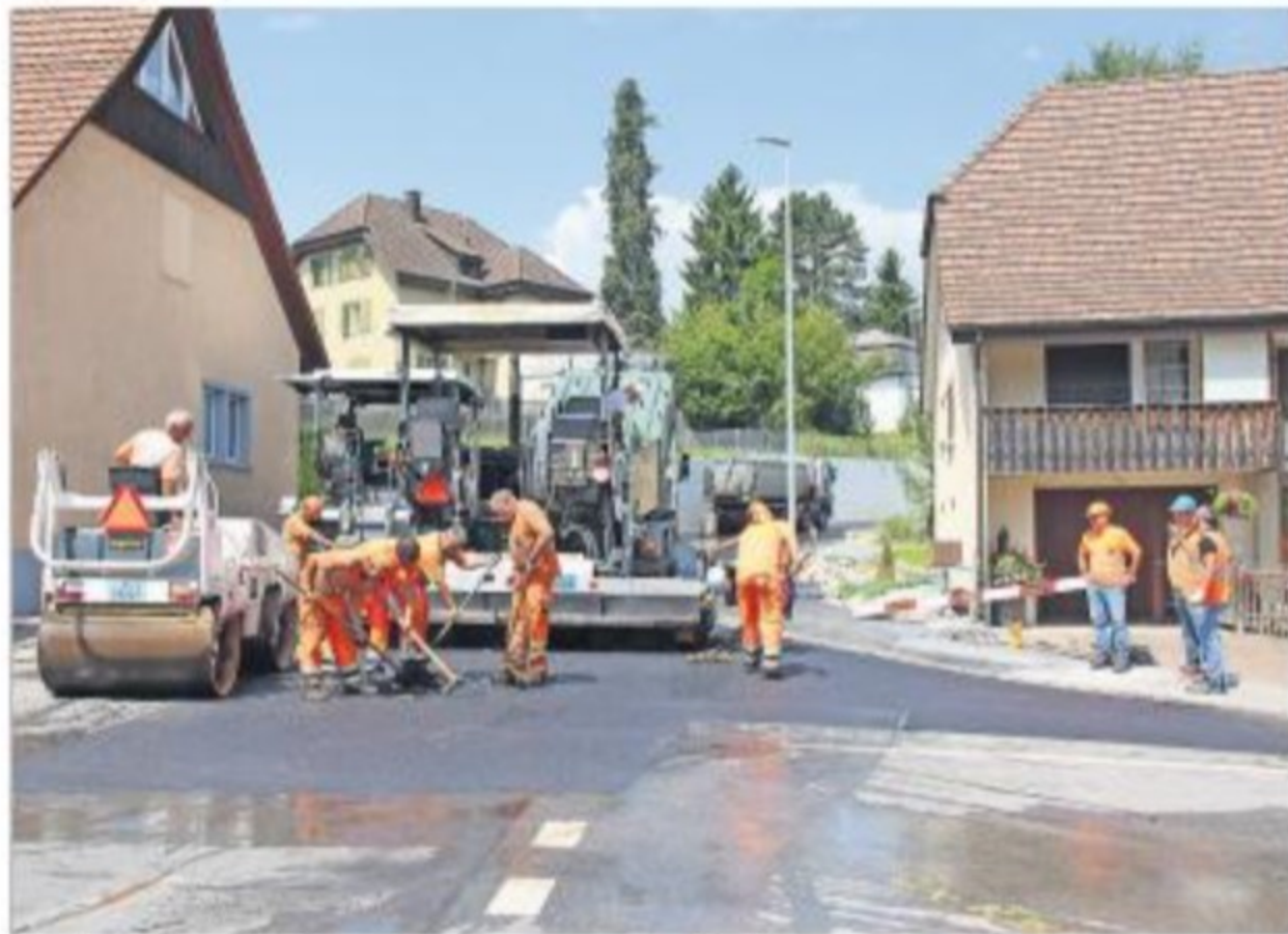
Schlusspunkt: Einbau des lärmarmen Deckbelags.
